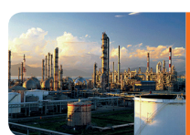
Une raffinerie avec ses installations d'hydrotraitement
