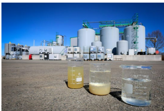
Enviropôle par PSI, gestion des déchets des entreprises du Grand Sud-Ouest. © PSI
